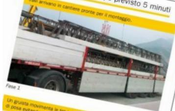
Un girata movimento le travi dai camion direttamente allo spazio di posa evitando così di predisporre uno spazio di stoccaggio.
